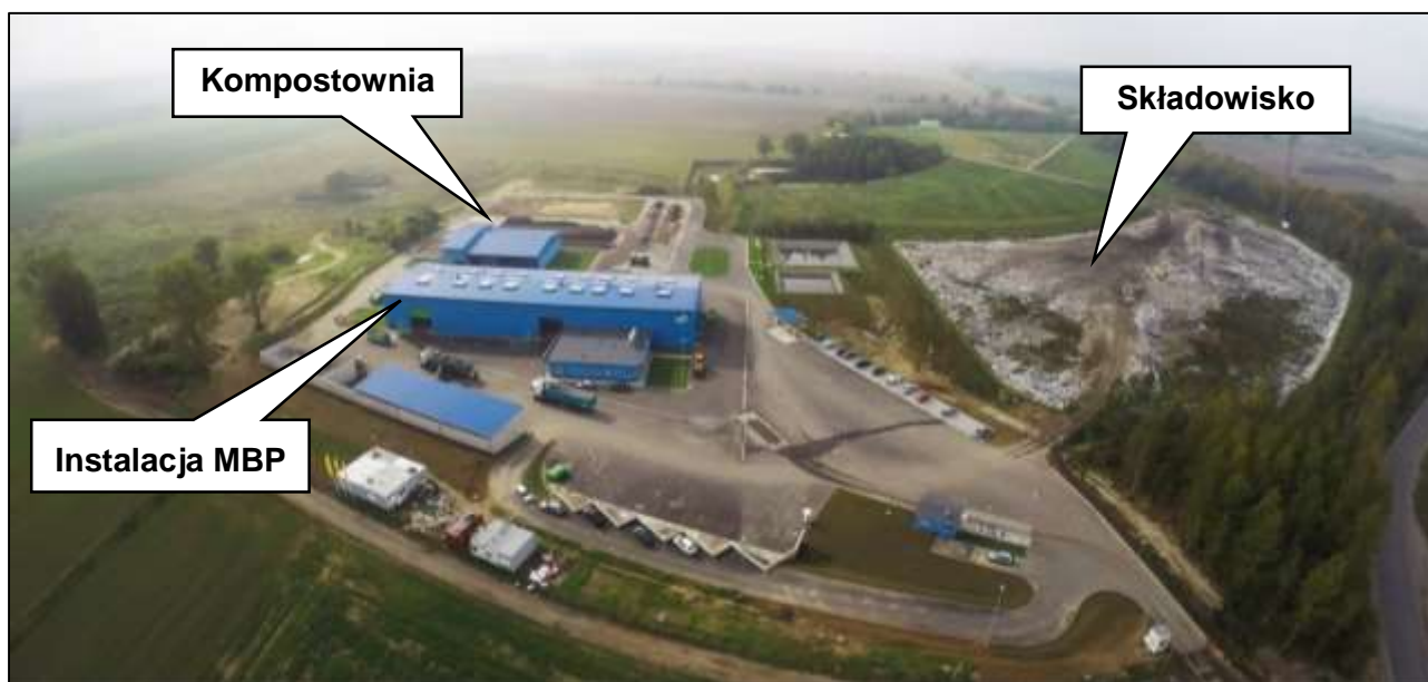
Fotografia 9. Instalacje RIPOK w Łęczycy, gm. Stara Dąbrowa
